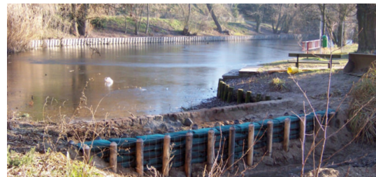
„Nährstoff-Falle“ mit FerroSorp® GW (2 - 4 mm) in Filtersäcken
