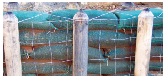
Detailansicht der Barriere aus Filtersäcken
